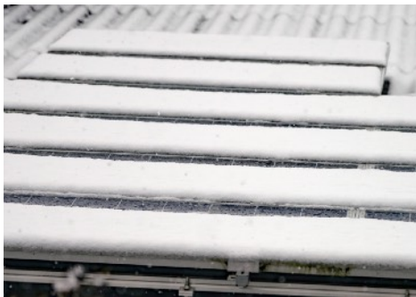
Bild: Schnee auf der PVA hat niemand gerne. Vorsicht! Das Entfernen kann Schäden verursachen.
